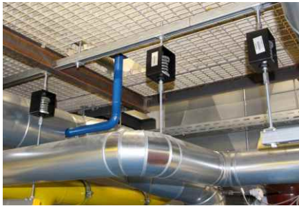
Aufhängung Rohrleitung mit Isotop® SD/Z
